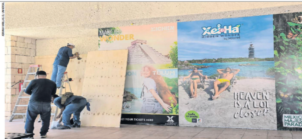
Trabajadores colocaban ayer tablas de protección en un embarcadero de Punta Cancún, en el corazón de la zona hotelera.
