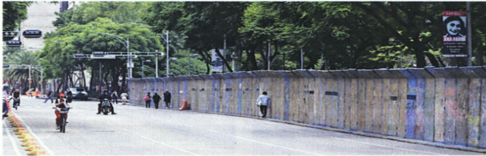
Tan súbita fue la instalación del cerco metálico, que no se contempló delimitar espacio para peatones.
