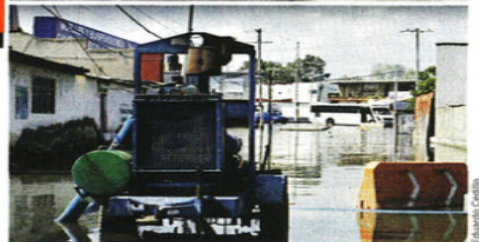
BAJO EL AGUA. El que será el carril confinado del Trolebús sumó cinco días anegado por las lluvias.
