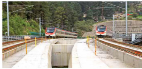
Foto: Especial Como parte de las evaluaciones se verifica la seguridad estructural antes, durante y después del paso de los trenes.
