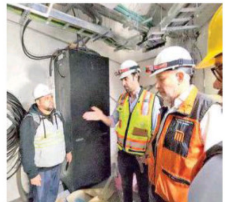
Andrés Lajous y Guillermo Calderón supervisan trabajos en Línea 1 /CORTESÍA: STC METRO
