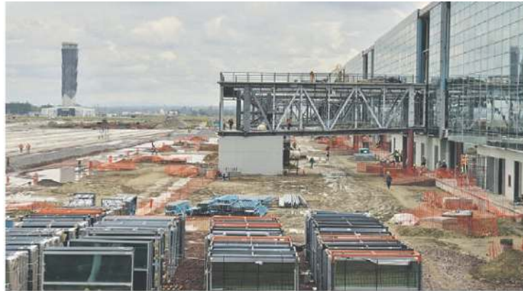
PARA 2022. El aeropuerto 'Felipe Ángeles' tiene un avance de 70 por ciento de obra.
