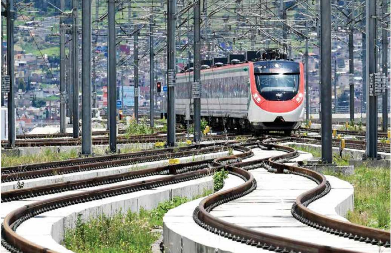
EN RUTA. Iniciaron las pruebas de los carros en las vías, para la próxima puesta en operación del transporte de pasajeros.
