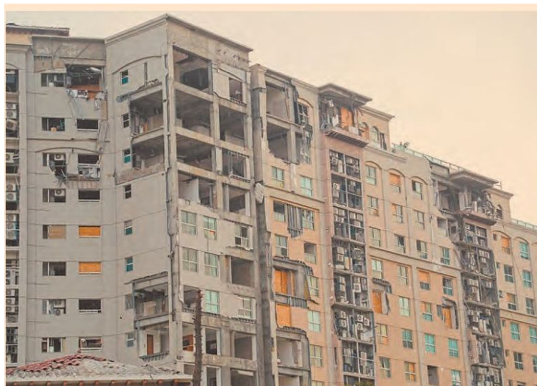
Una de las lecciones que han dejado los desastres naturales recientes, es desarrollar infraestructura resiliente. FOTO EE: HUGO SALAZAR
