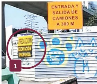
EN EL SITIO, un letrero advierte que se trata de una excavación profunda.
