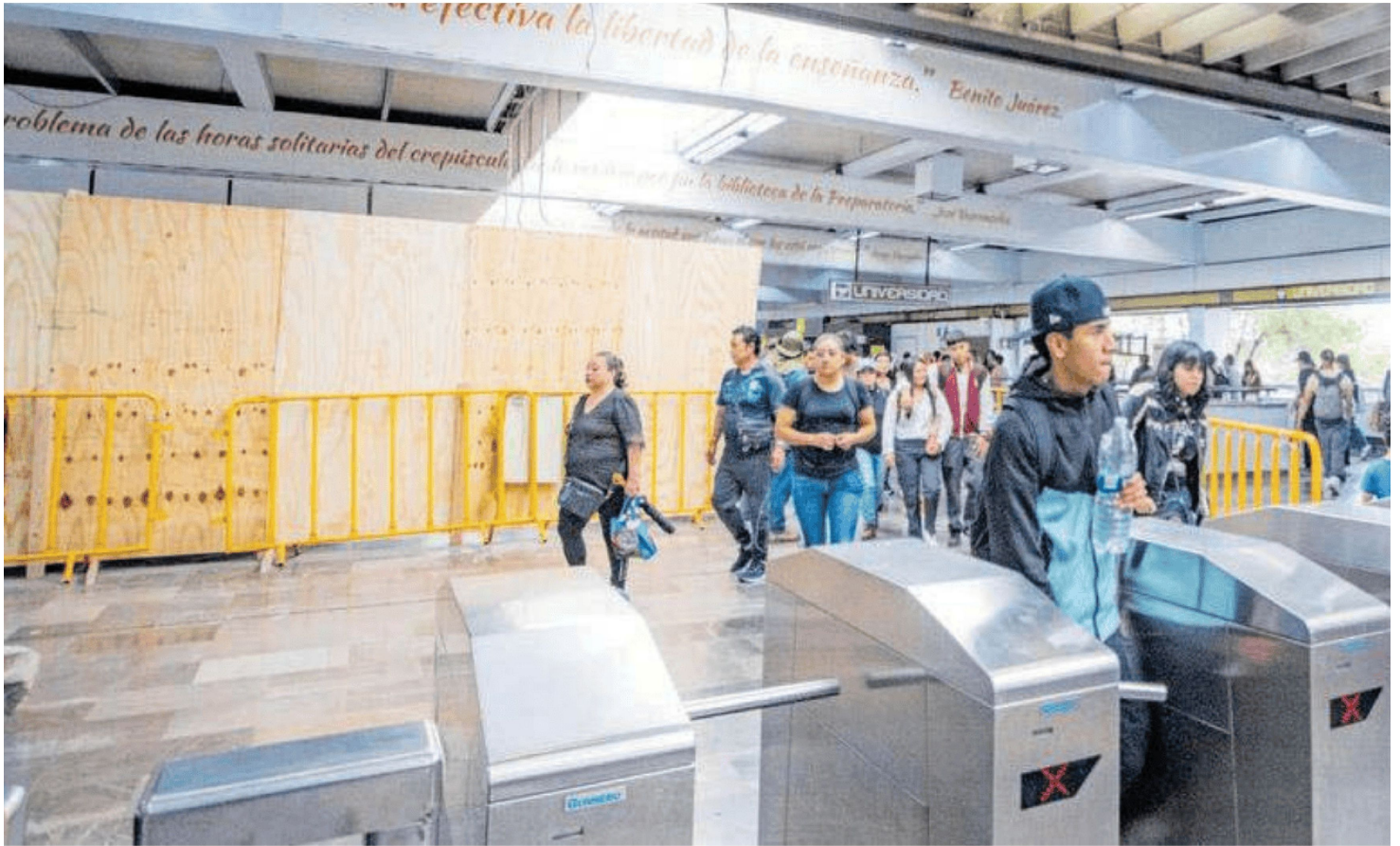
Pasajeros de Metro Universidad sortean el inicio de las obras en la estación
