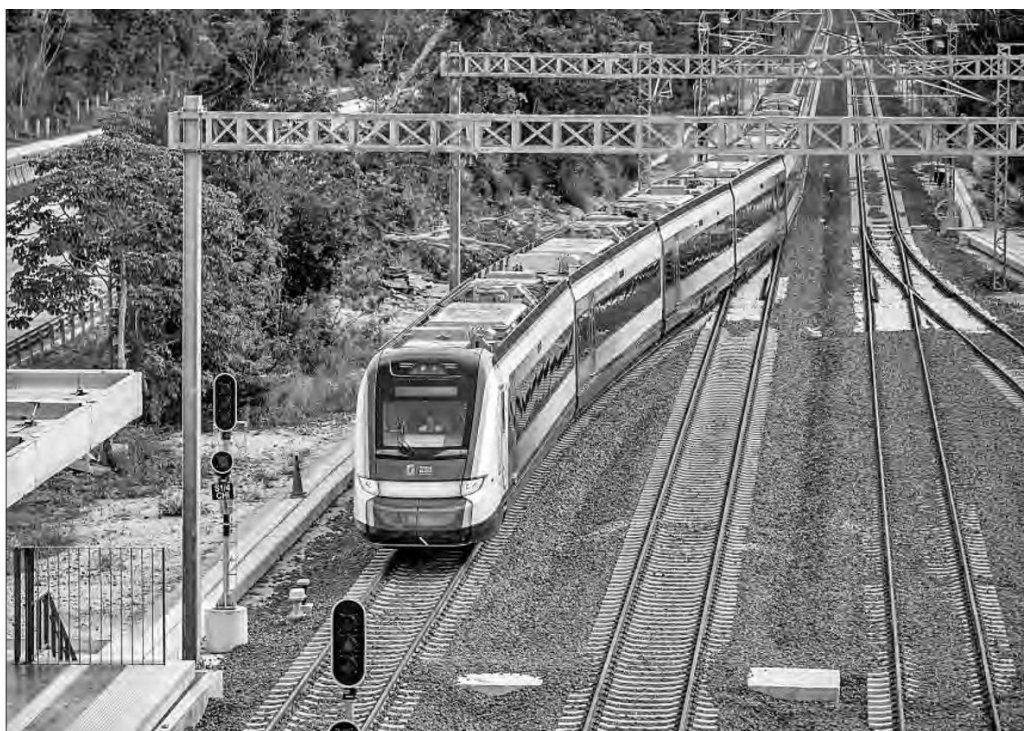
▲ Entre las medidas de reparación que mencionó la dependencia está la eliminación de mallas que impiden el paso de la fauna. Foto Jair Cabrera Torres
