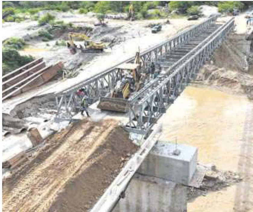
Ingenieros y trabajadores de la SICT agilizaron las maniobras para poner en operaciones el armazón de acero, de 90 mts de longitud y 30 toneladas de capacidad de carga.
