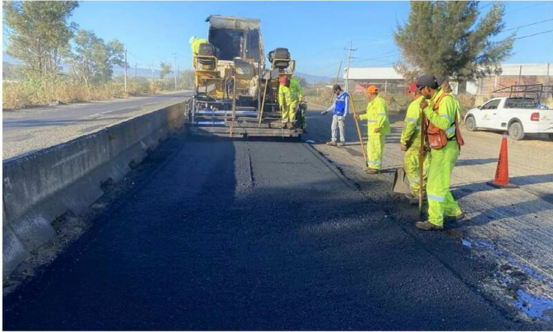
■ Realizan trabajos de bacheo en 47 kilómetros, con la suma de los dos sentidos de circulación.
