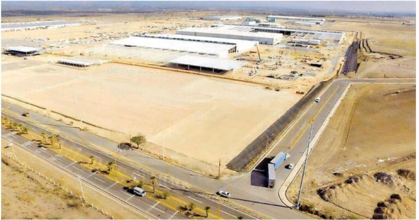
El complejo de manufactura inició su fase de equipamiento en 2016
