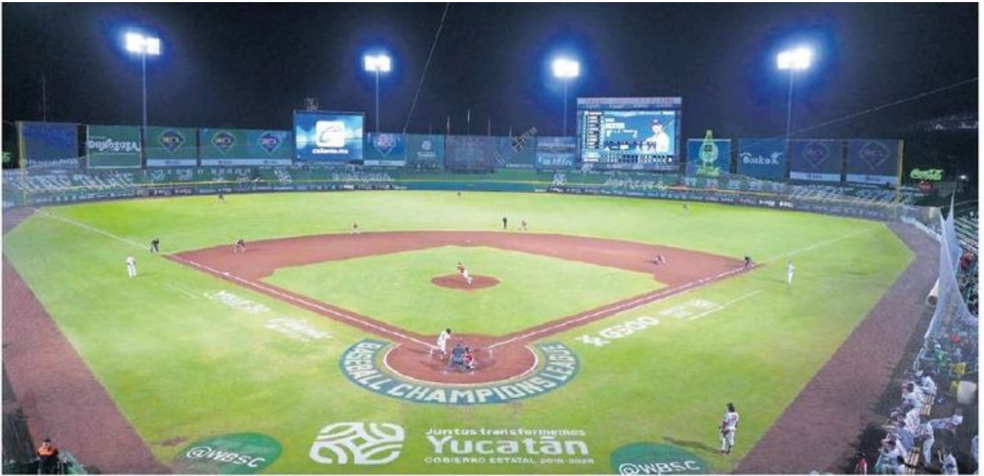
La remodelación del estadio de beisbol de Mérida, Yucatán, es una obra más que se suma a las labores de las Fuerzas Armadas en esta administración.
