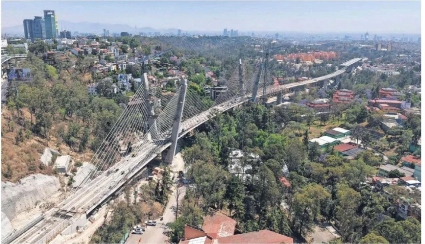
El puente atirantado del Tren Interurbano México-Toluca, es uno de los últimos tramos de la obra y permitirá su conexión hacia Observatorio.
