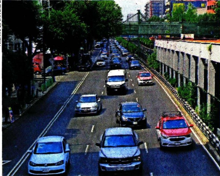
Durante este año se tienen previstas obras sobre la calzada de Tlalpan, como parte de las mejoras en movilidad de cara a la Copa del Mundo.
