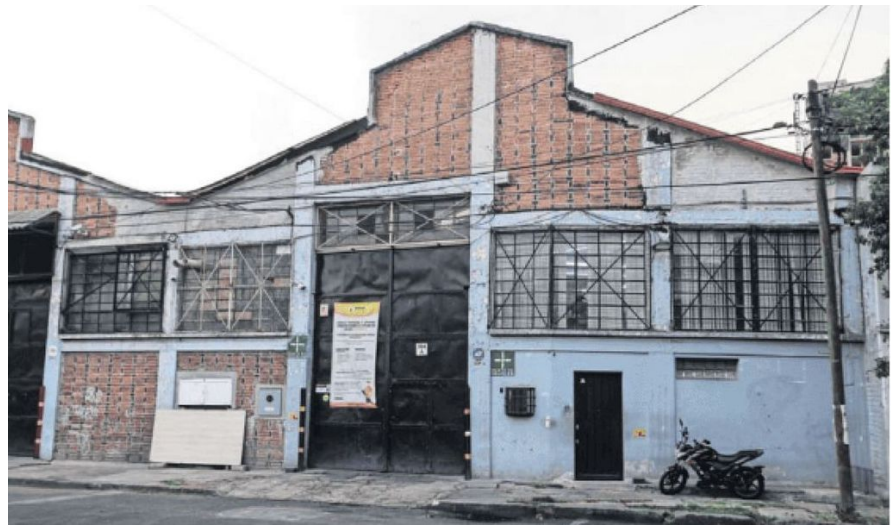
En la colonia Arenal, en Azcapotzalco, se ubican los predios de Chopo 594 y 598; el lugar se ve deteriorado y ahí se pretende construir casas-habitación y comercios.
