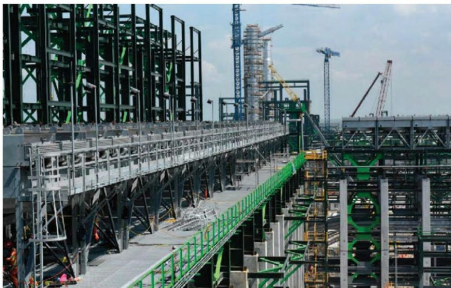
Refinería Dos Bocas.
