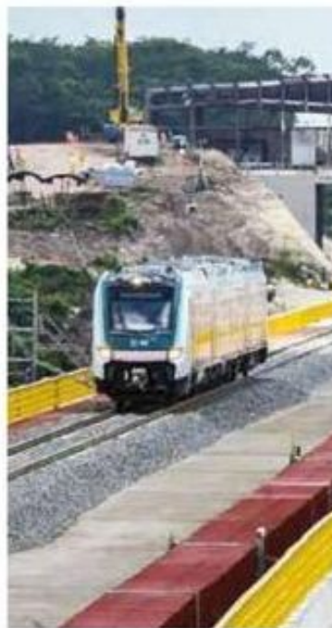
Daños. La estación del Tren Maya en Campeche.
