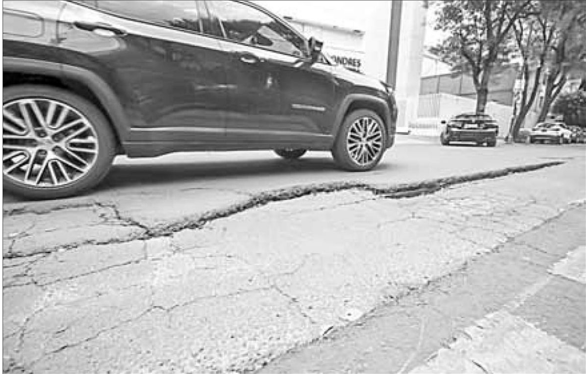
▲ Frente a la Clínica Londres, en la Roma, hay un hundimiento en un franja de 40 metros. Foto Yasmín Ortega Cortés
