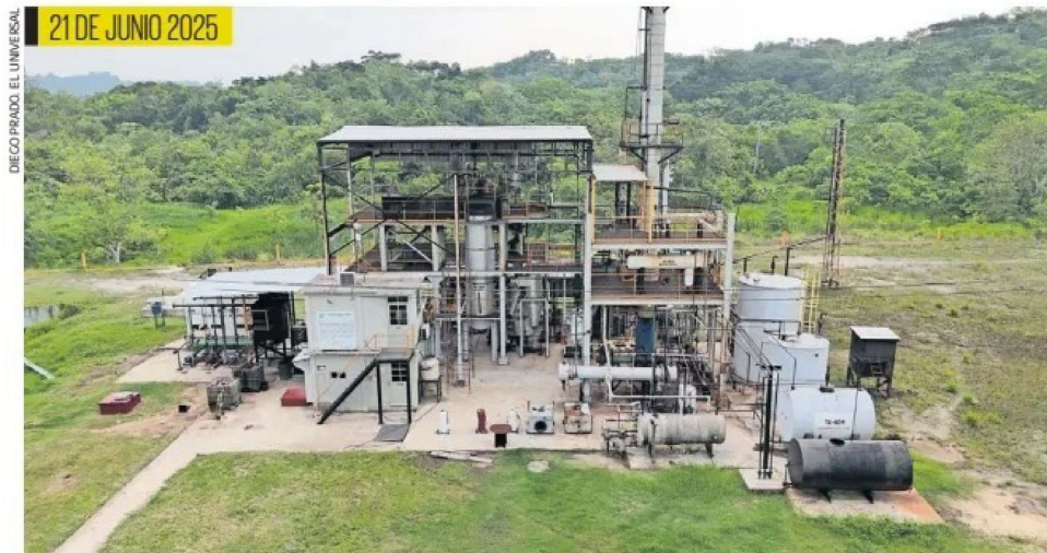
21 DE JUNIO 2025 En este año se observa que la planta ya está en forma y fue dotada de un contenedor de grandes proporciones para almacenar combustible, y hay constante presencia de pipas y tráileres dentro de las instalaciones.
