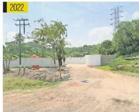
2022 En mayo de ese año se retira el alambre de púas y las láminas que son sustituidas por una barda de cemento.
