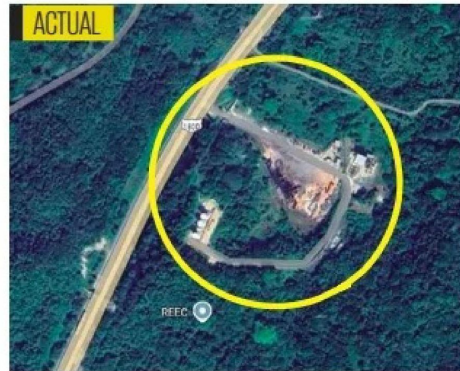
ACTUAL La planta siempre permaneció sin algún distintivo de su nombre o razón social y sin pavimentación.
