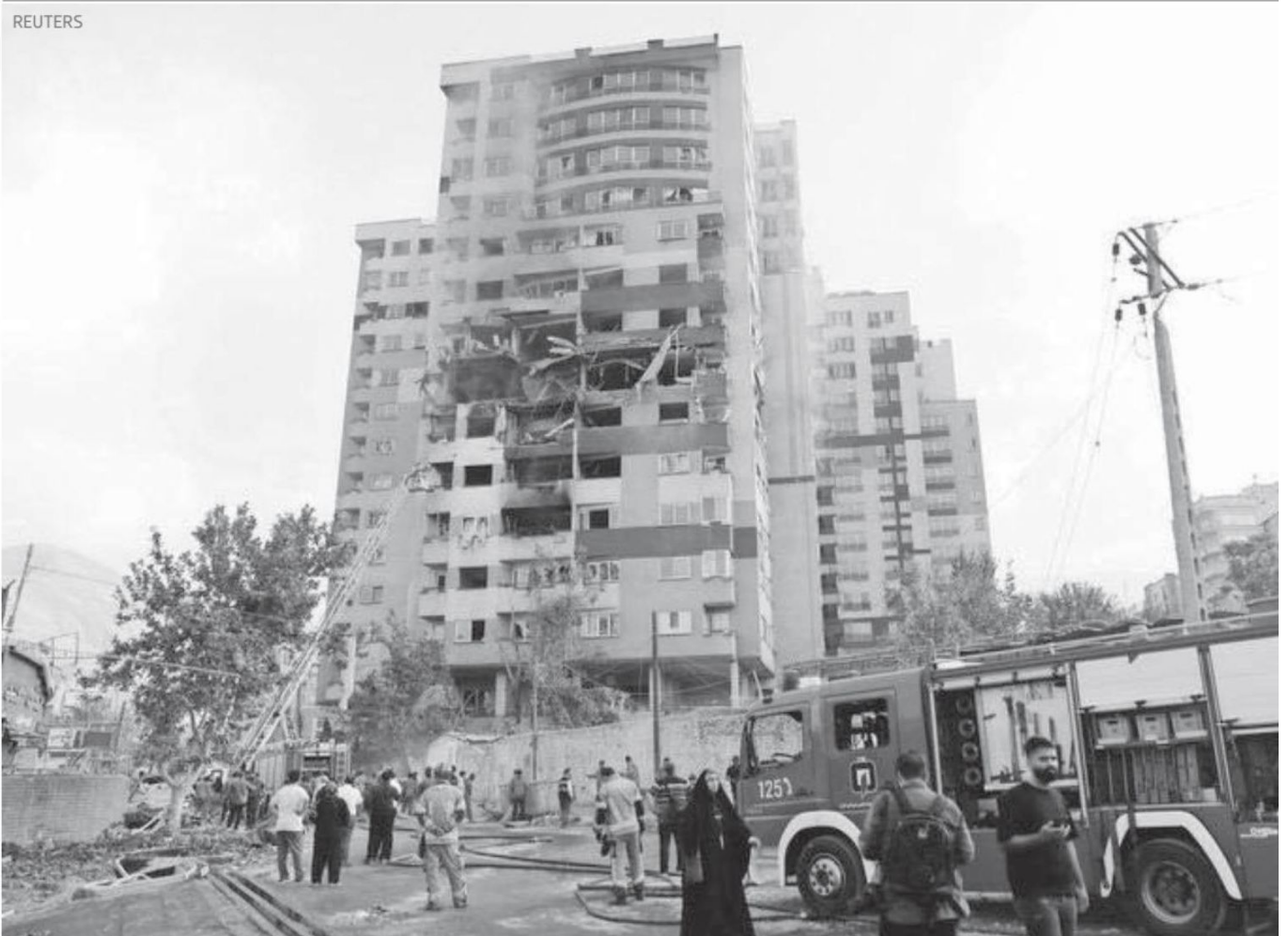
Los bomberos trabajan en la escena de un edificio dañado tras los ataques israelíes, en Teherán
