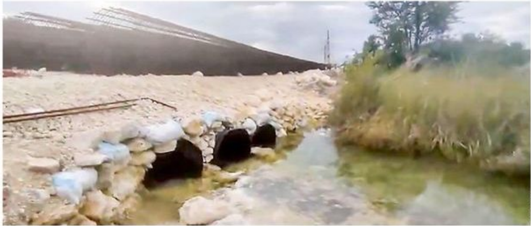
OBRAS. Organizaciones acusan que en el Tramo 6 se han rellenado manglares y colocado tuberías para permitir el flujo del agua, afectando al ecosistema.
