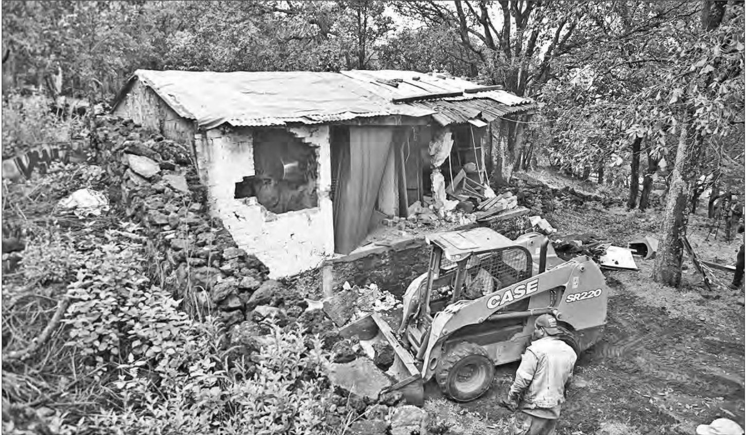
▲ En terrenos que forman parte del núcleo agrario de San Andrés Totoltepec se demolieron tres construcciones irregulares y se resguardaron 20 mil metros cuadrados de área de valor ambiental. Foto La Jornada
