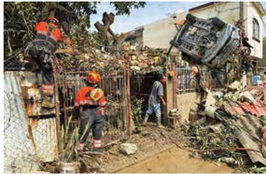
● AYUDA. Protección Civil trabaja en la limpieza.
