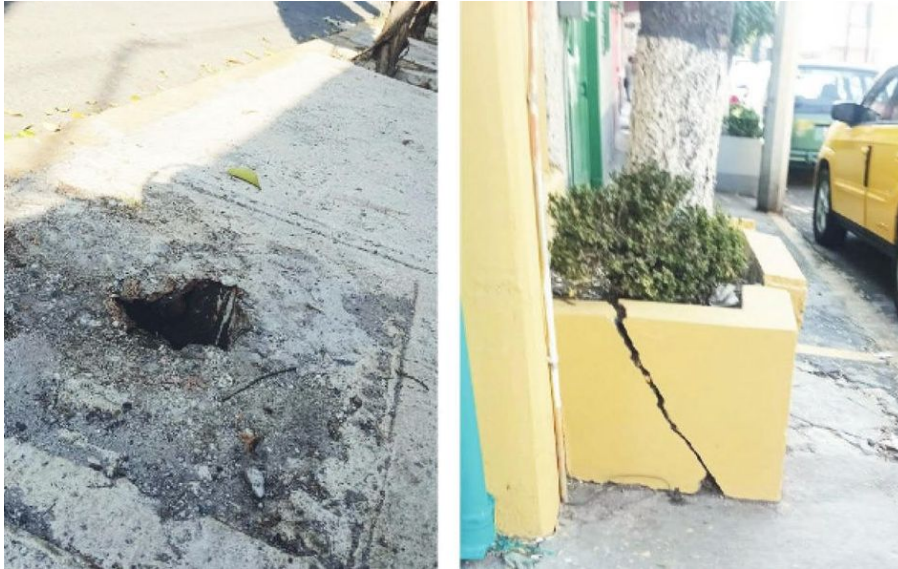
El objetivo de la restauración en las banquetas era retirar el adoquín
