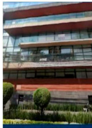
Edificio ubicado en el 1909 de avenida Coyoacán y que resultó afectado por una explosión. Tenía dictamen de habitabilidad.
