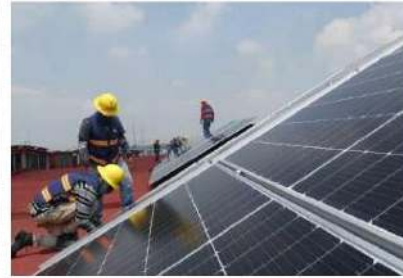
La empresa encargada de la obra es Fortius Electromecánica. Especial
