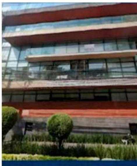
Edificio ubicado en el 1909 de avenida Coyoacán y que resultó afectado por una explosión. Tenía dictamen de habitabilidad.
