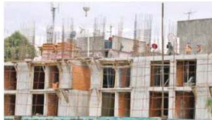
Ya se construyen algunas viviendas en un lote donado por Petróleos Mexicanos /SERGIO VÁZQUEZ
