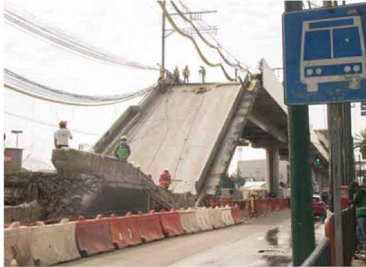
El 2 de mayo de 2021 , un tramo elevado de la Línea 12 del Metro colapsó, provocando la muerte de 26 personas.
