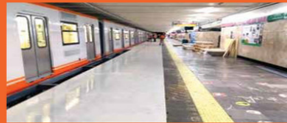
Foto: Especial Al cierre de esta edición, aún se colocaba la tarima de abordaje que convertirá la estación Balderas en terminal.
