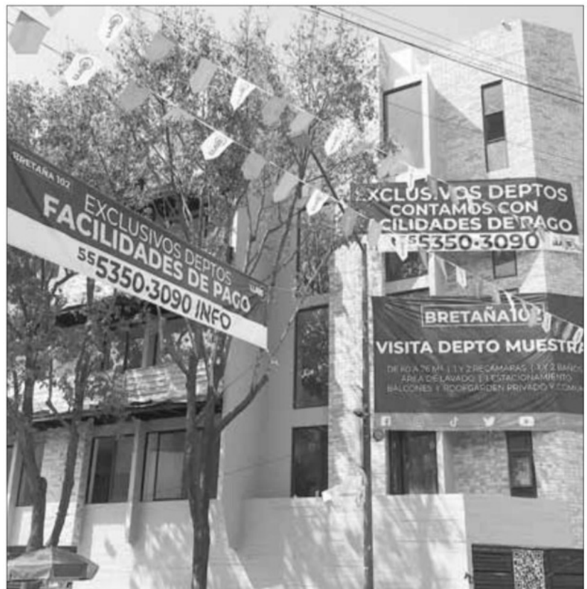
▲ Edificio de departamentos en venta en la colonia Zacahuitzco, en la alcaldía Benito Juárez. Vecinos de la demarcación han denunciado ante las
