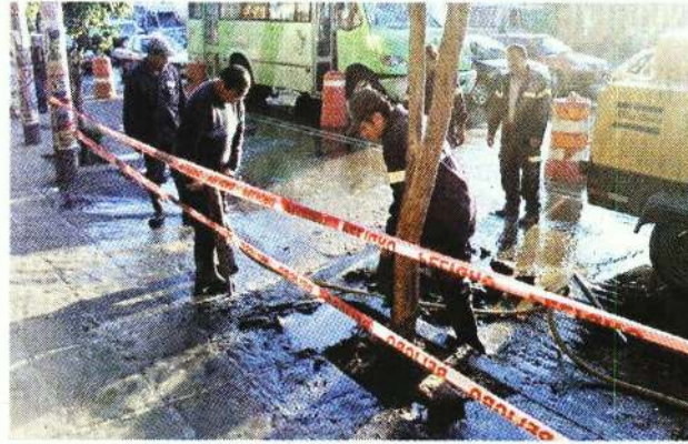
■ Los sistemas de georradar permiten ubicar oquedades e instalaciones hidráulicas en el subsuelo.
