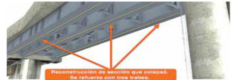
Reconstrucción de sección que colapsó. Se refuerza con tres traves.
