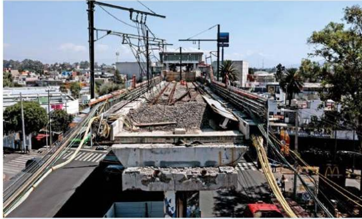
ESPECIALISTAS. A la fecha se ha certificado a 320 soldadores, quienes trabajarán en la rehabilitación y el reforzamiento del tramo elevado.
