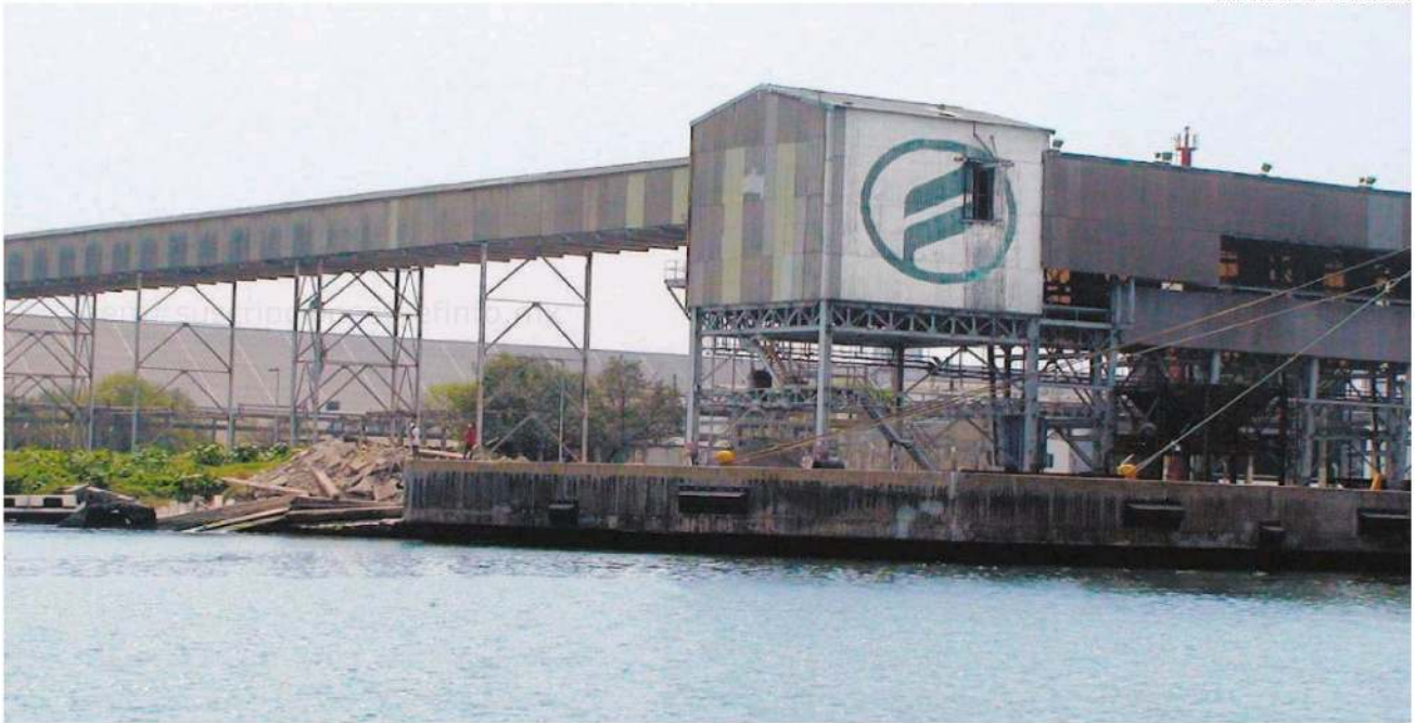
Planta Fertinal en el puerto de Lázaro Cárdenas, Michoacán
