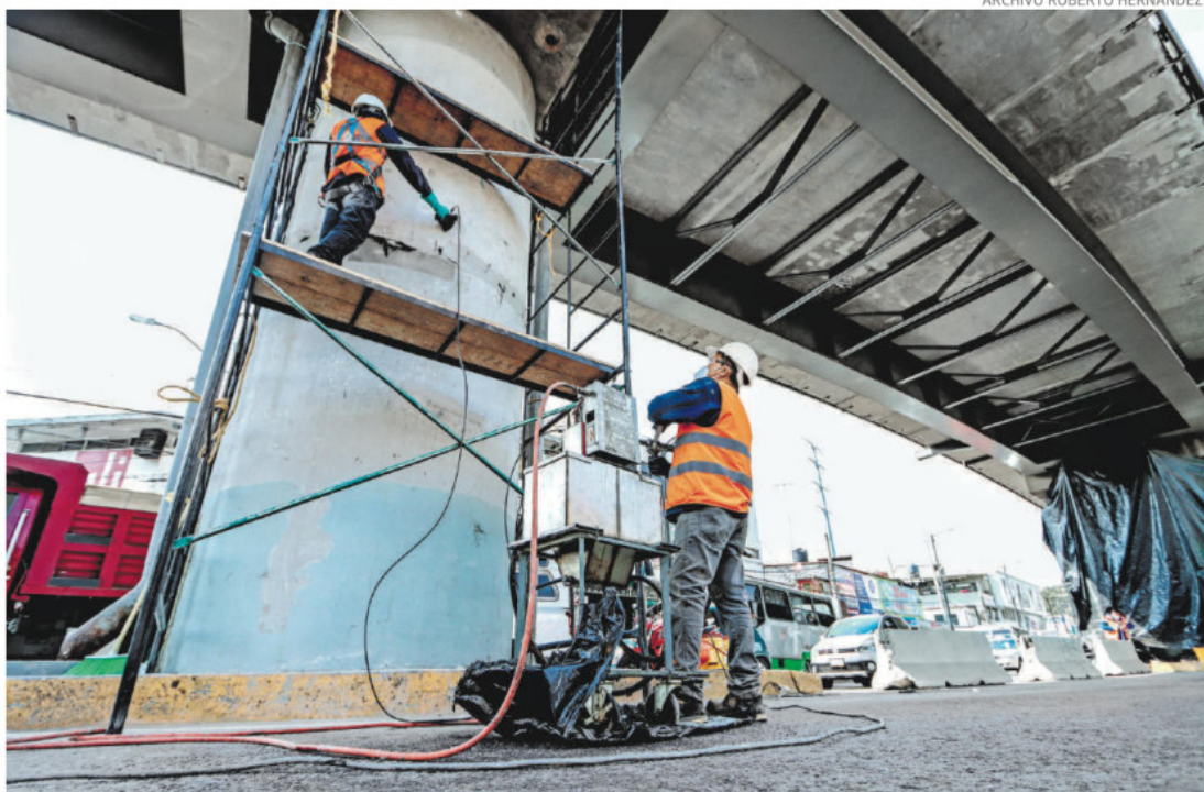
El gobierno mantiene la promesa de terminar este año los trabajos y reabrir para 2023
