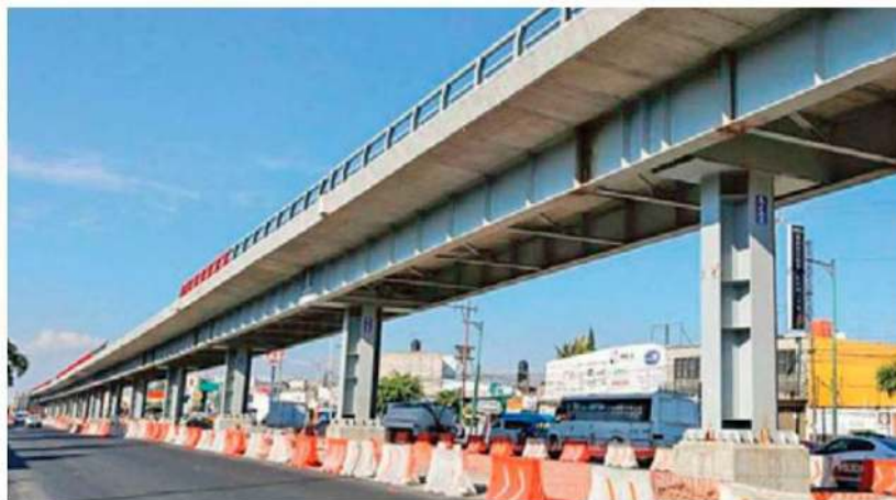
Tramo elevado de la Línea Dorada del Metro.
