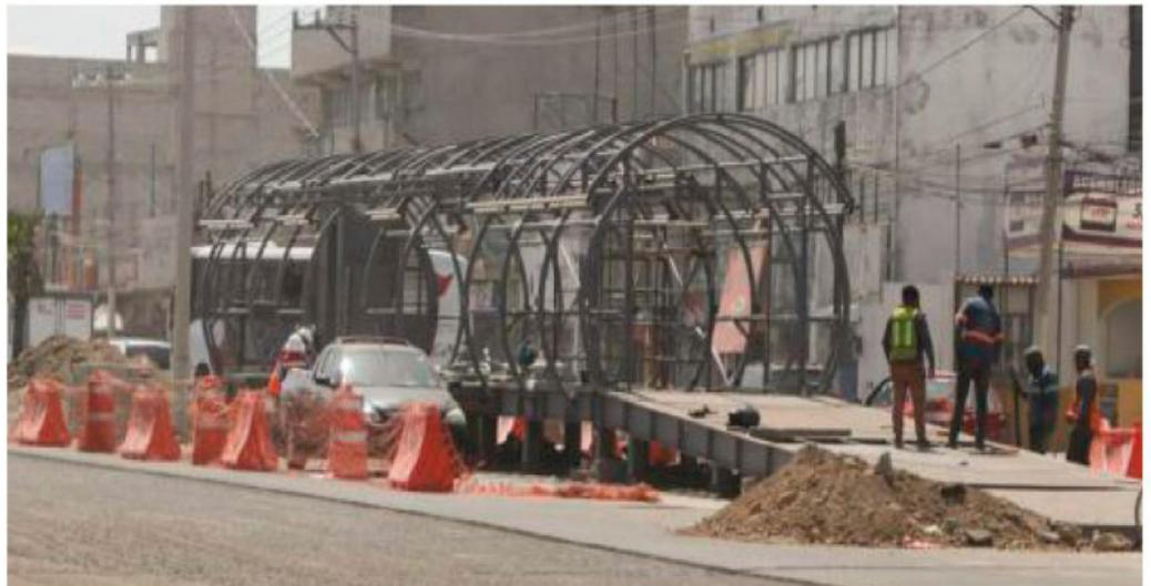
Instalación de una de las estaciones del Mexibús mediante sistema prefabricado de acero.
