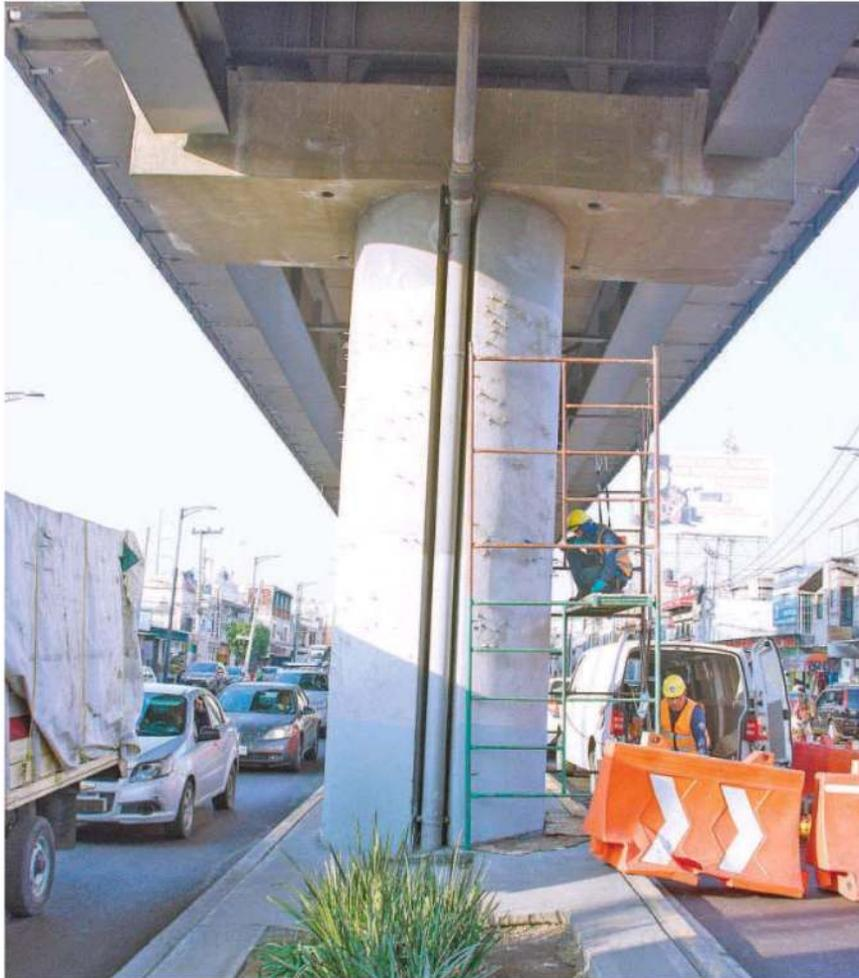
**Al iniciar** los trabajos de reparación de las columnas de la línea 12 del Metro se limpiaron las columnas para descubrir las grietas y fisuras /DAVID DEOLARTE
