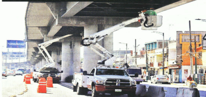
RECONSTRUCCIÓN. En Avenida Tláhuac comenzaron los trabajos de rehabilitación de la Línea 12 del Metro, la cual prevén las autoridades finalizar para octubre.
