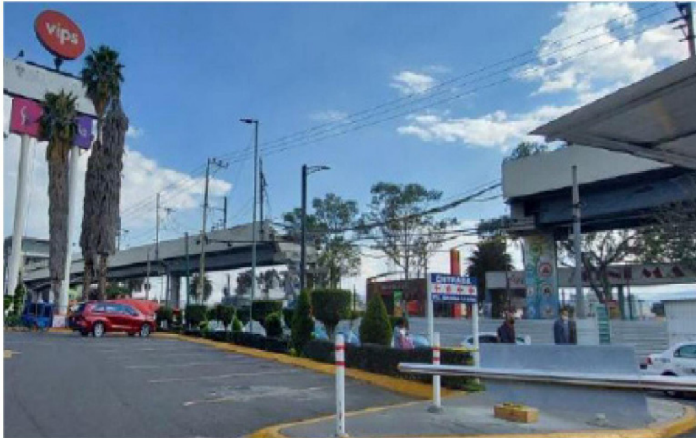
Luego del retiro de la estructura colapsada de la L-12 y la limpieza de escombros en la zona del derrumbe, la circulación sobre Avenida Tláhuac es mayor, aunque la presencia de 500 autobuses del servicio emergente que reemplaza al del Metro complican el desplazamiento.
