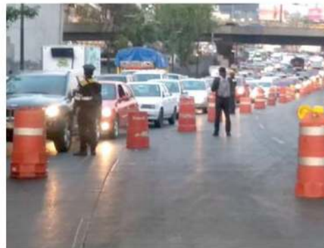
- Las obras, hasta el martes 15
