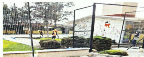
Los trabajadores señalaron que comenzaron con diversas labores en el predio del refugio cercano al nuevo aeropuerto.
