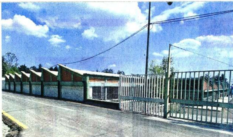
Instalaciones donde estará la Bodega Nacional de Artes y Talleres de Arte y Oficios; tendrá cuatro bodegas de arte, una bodega visitable, mediateca y biblioteca, entre otros espacios.
