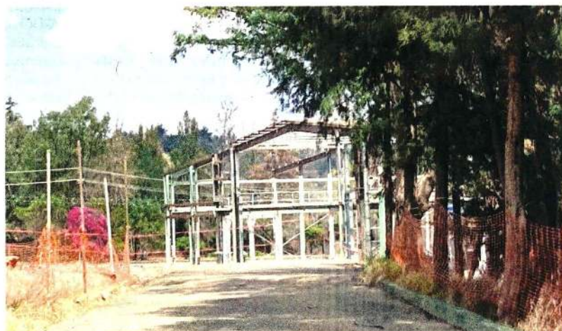
Estructura de la exensambladora donde estará la Cineteca Chapultepec que tendrá, entre otros espacios, dos salas de cine para 400 personas; cuatro para 200 y dos para 100.
