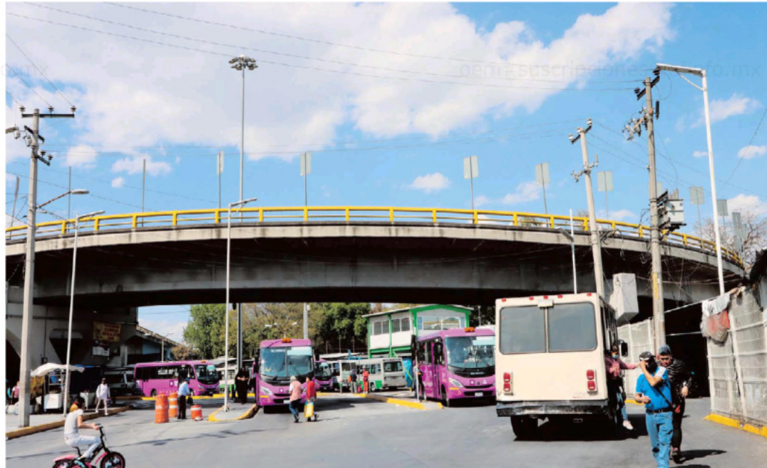
En Calzada Legaria ya circulan las unidades renovadas que aceptan la tarjeta de movilidad integrada
