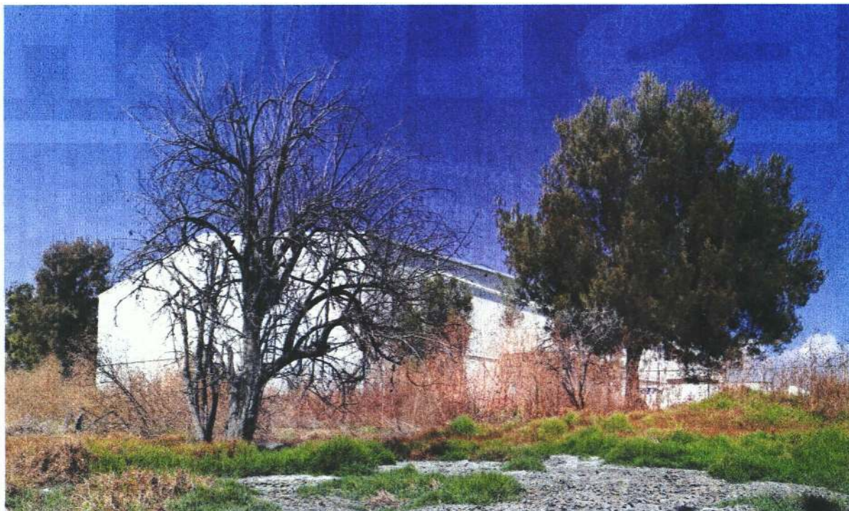
En 2021, Conagua impuso tres multas al parque industrial Ciudad Textil por descargar ilegalmente líquidos residuales, obstaculizar la labor de fiscalización y no tener los dispositivos para medir la calidad del agua; ninguna ha sido pagada.
