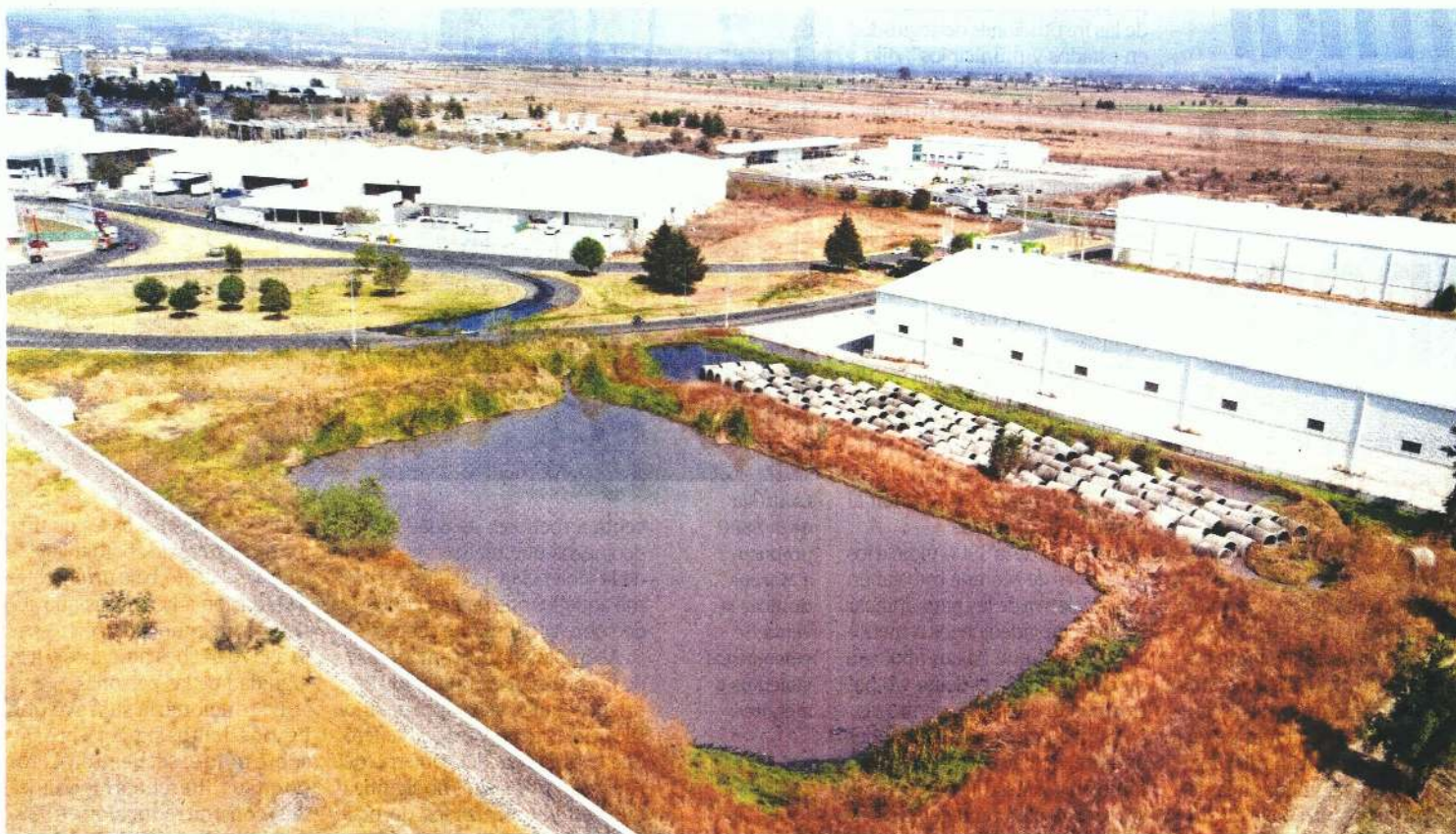
El parque industrial Ciudad Textil, en Puebla, tiene en sus terrenos una laguna del tamaño de una nave empresarial con agua color metálico; es uno de los tanques de oxidación donde las instalaciones de esta área manufacturera descargan sus vertidos y líquidos residuales.
