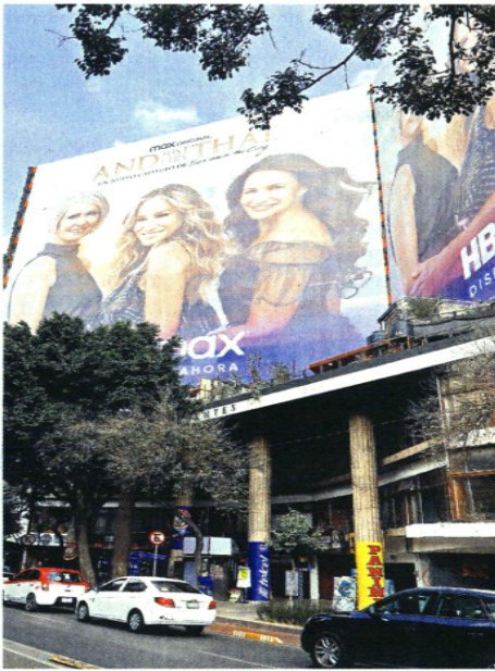
■ Las lonas colocadas sobre las dos fachadas principales están prohibidas por la Ley de Publicidad Exterior.
