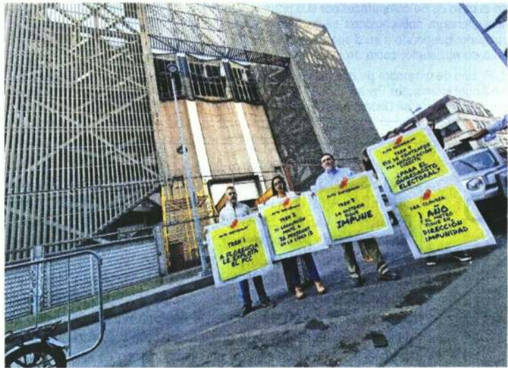
Diputados locales panistas como Federico Döring (centro), protestaron afuera de la Subestación de Buen Tono del Metro.
