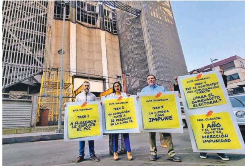
A un año del incendio en la subestación eléctrica, diputados locales del PAN acusaron corrupción y negligencia /CORTESÍA
