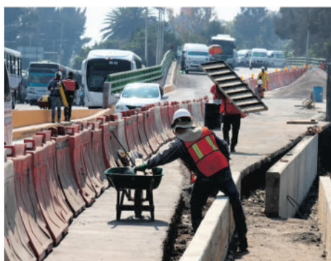
Del lado oriente los trabajos van más avanzados
