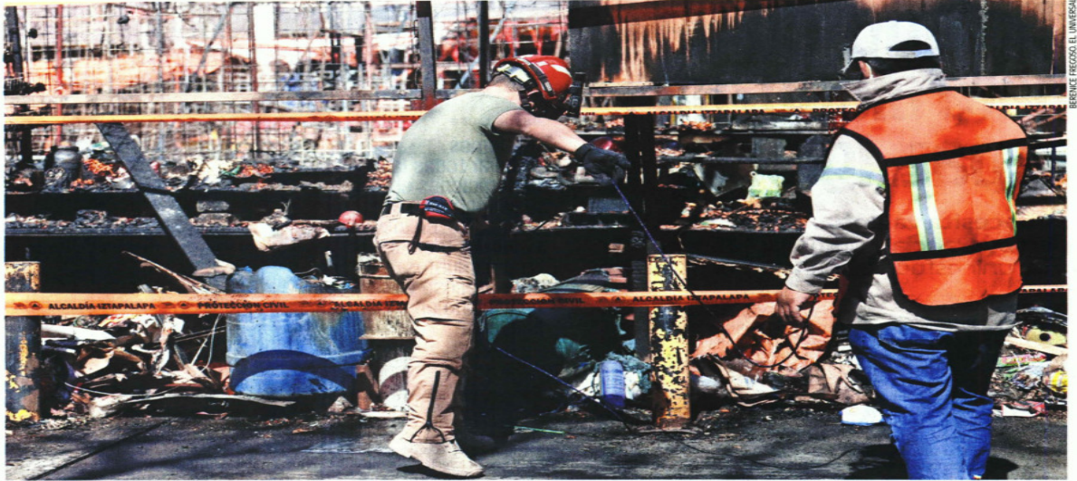
Afuera del Mercado La Purísima, decenas de trabajadores de la alcaldía Iztapalapa y Protección Civil movieron estructuras de los puestos para facilitar la limpieza.
