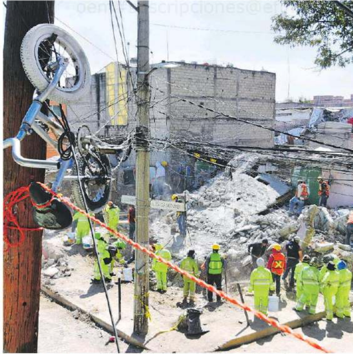
Ayer se realizaron los trabajos de remoción en la vecindad
