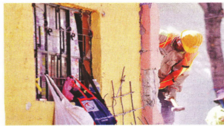
■ Las labores remoción de escombros siguen en esta colonia de Miguel Hidalgo desde el sábado.
