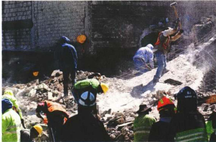
Trabajadores avanzan en la remoción de escombros en la zona donde explotó un tanque de gas LP, para iniciar con la reconstrucción.
