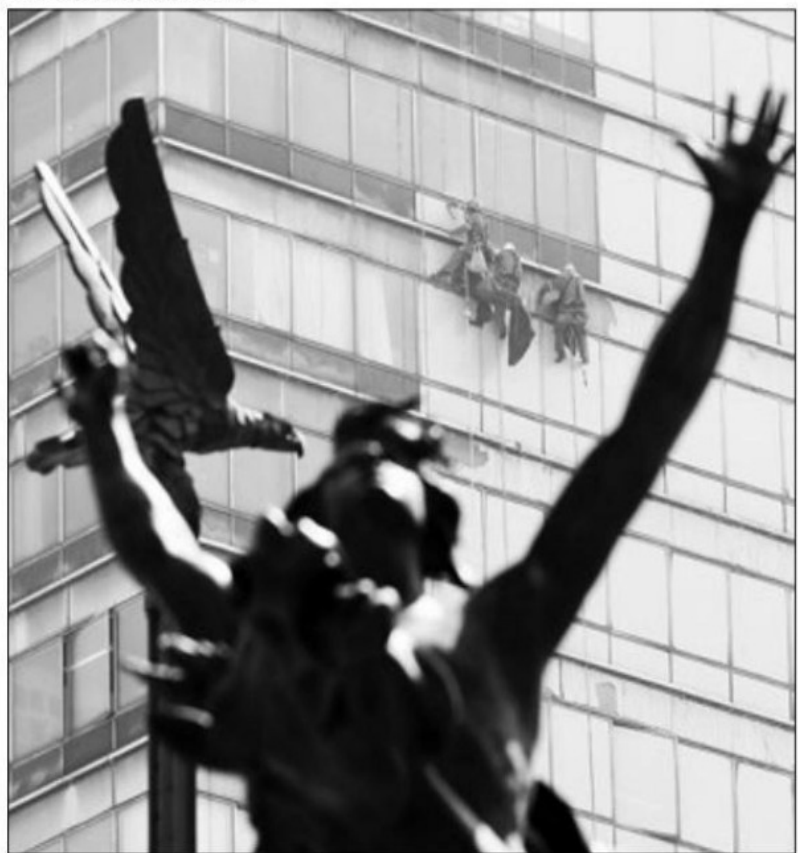
▲ Labores de limpieza en la ventanería de la torre Latinoamericana. Foto Roberto García Ortiz
