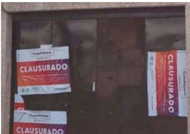
La semana pasada fueron colocados sellos de clausura a la construcción del edificio sede del PT, en avenida Cuauhtémoc.
