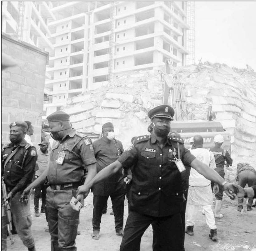
▲ Policias, rescatistas y militares fueron desplegados ayer en el área del derrumbe en la zona de Iyoki, en Lagos, la ciudad más grande de Nigeria. Foto Ap
