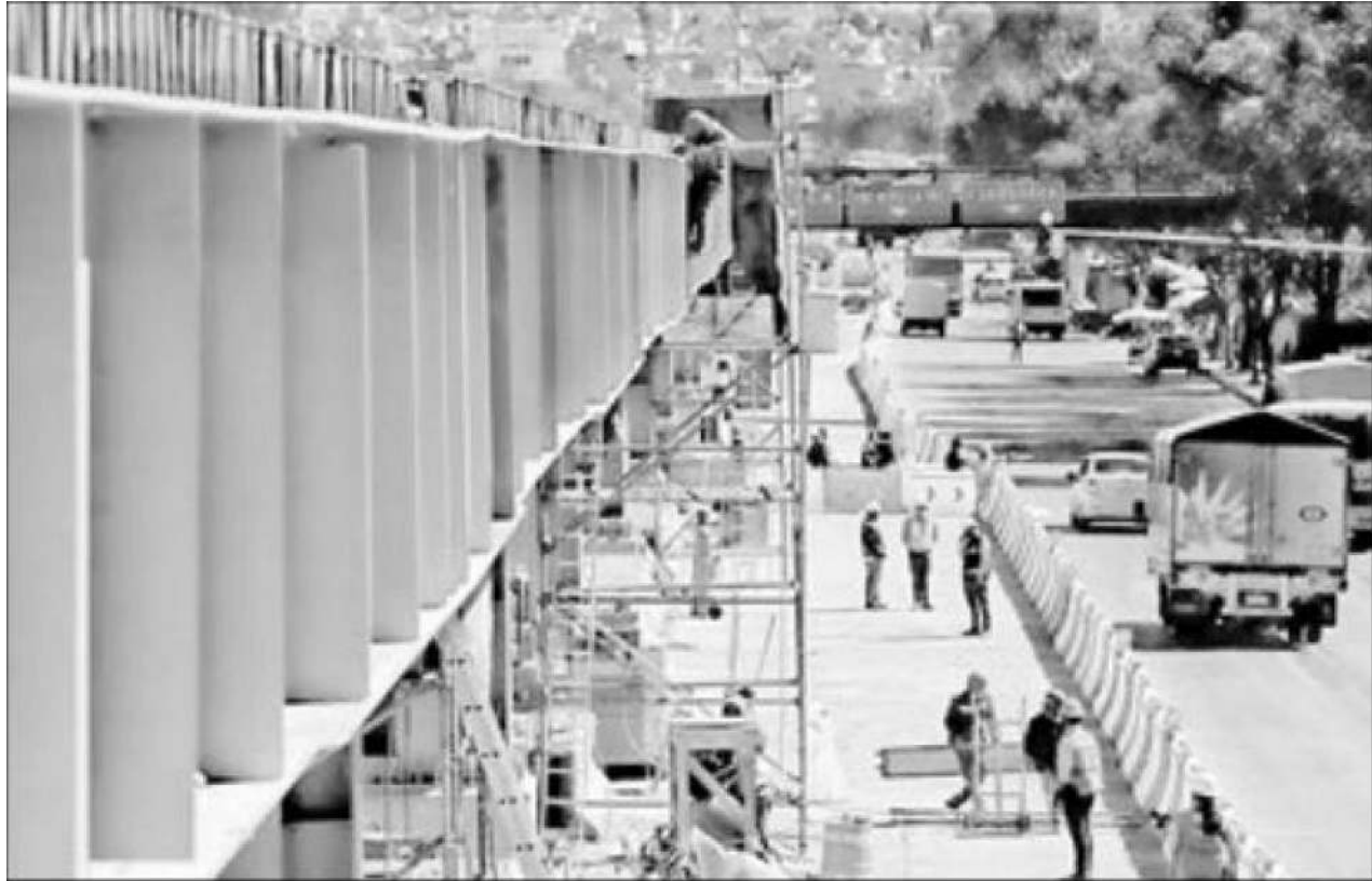
◀ Los trabajos de construcción del trolebús elevado en el Eje 8 Sur Ermita, que correrá de Constitución de 1917 a la UACM Casa Libertad, se intensificaron al entrar a la segunda semana consecutiva en semáforo verde epidemiológico. Foto Cuartoscuro
