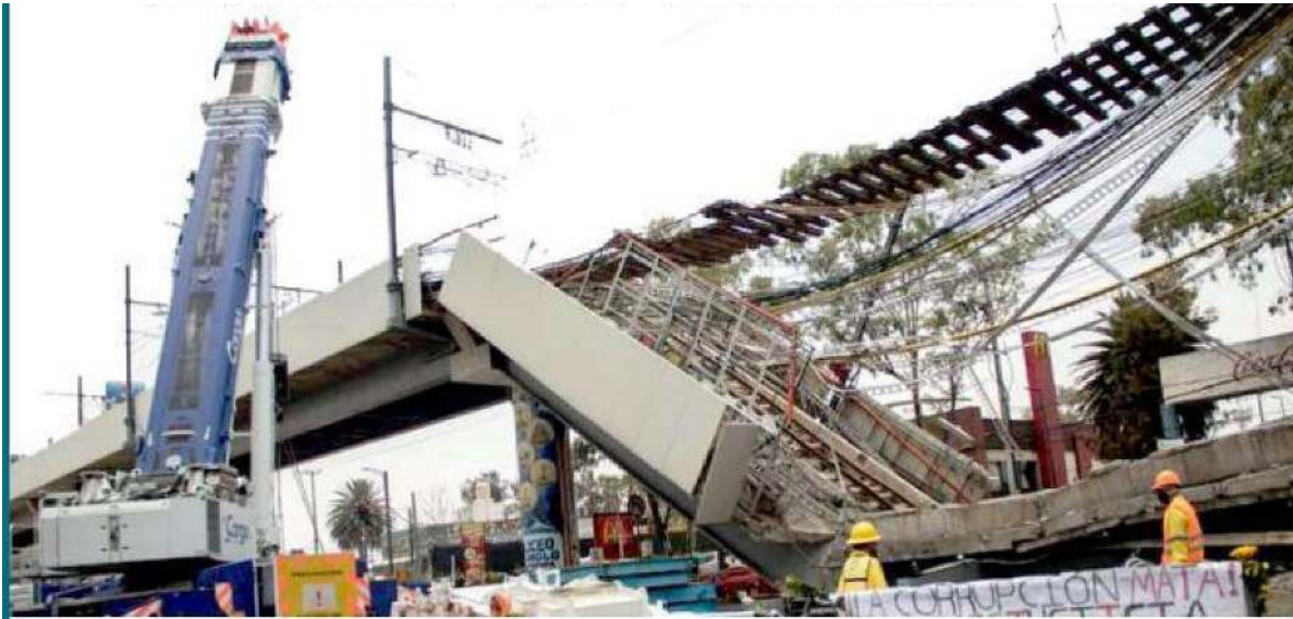
Grupo Carso comunicó que reforzará el tramo metálico elevado entre las estaciones Tezonco y Olivos
