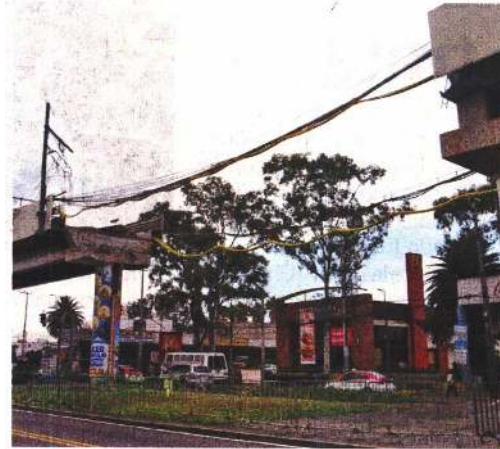
Parte de los trabajos abarcan la reparación del tramo colapsado.
