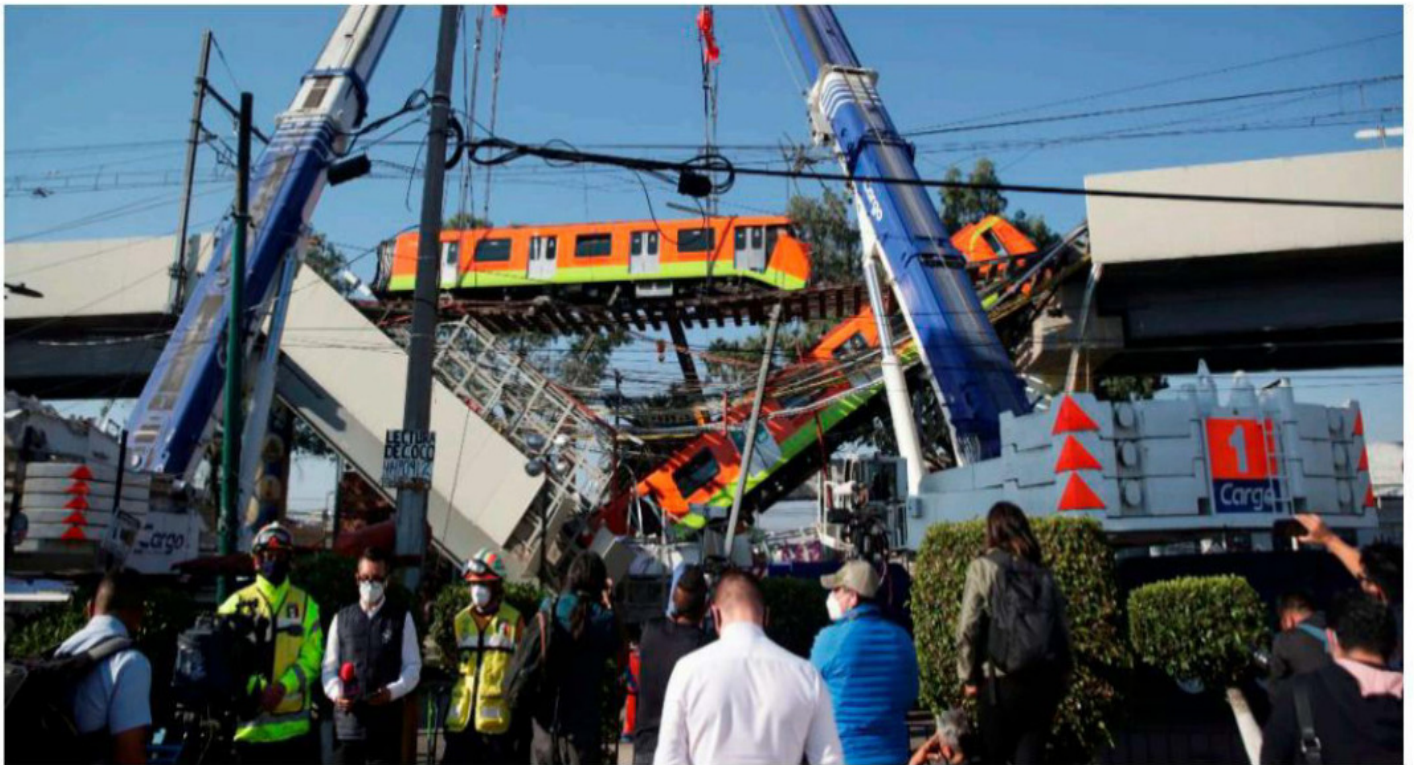
El colapso en la Línea 12 del Metro el pasado 3 de mayo que dejó un saldo de 26 personas muertas.
