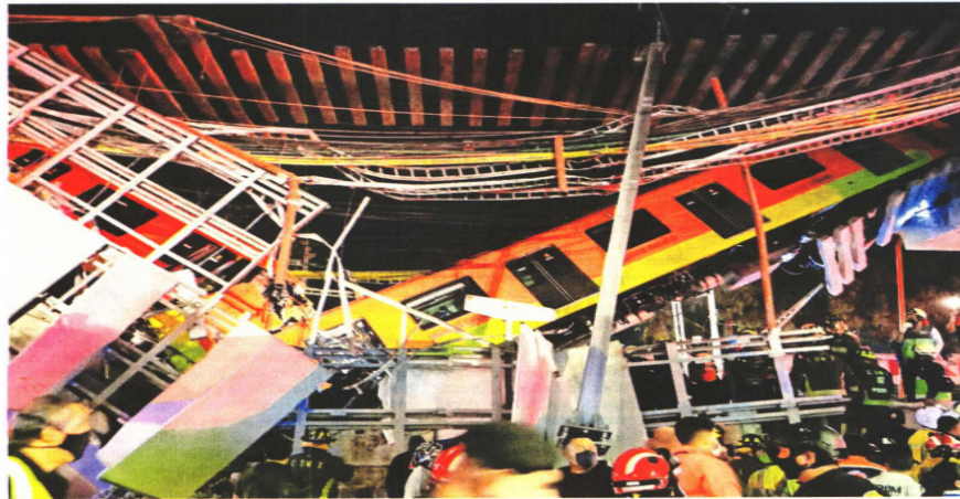
Los dos peritajes de la noruega DNV y el informe de la FGJ coinciden en que errores en construcción provocaron el colapso.
