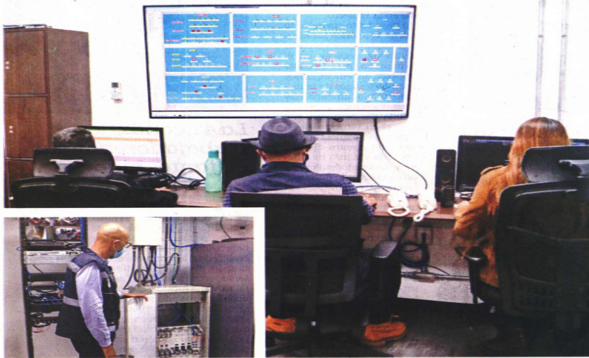
De acuerdo con las autoridades del Metro, el sistema Tetra, encargado de la comunicación con las redes del STC para monitorear a los trenes, fue certificado en abril de 2020 y cuenta con un respaldo en otras instalaciones.
