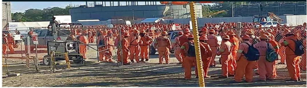
Trabajadores de ICA suspendieron las obras en la refinería de Dos Bocas; la Marina resguarda las instalaciones.
