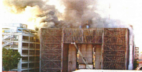
El incendio en el Puesto Central de Control, en enero pasado, afectó la comunicación de las líneas 1 a la 6 del Metro.
